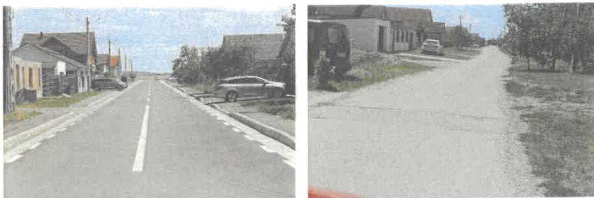
Figura nr 19 Stradă asfaltată pe stânga și respectiv pe dreapta stradă porțiuni din balast concasat alternând cu segmente de stradă asfaltate
